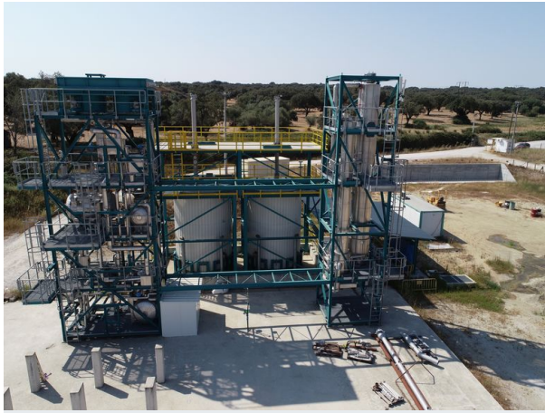
Flüssigsalz-Dampferzeugersystem (rechts) mit einer Höhe von 15 Meter und der Rückkühleinheit (links) (im August 2018)
