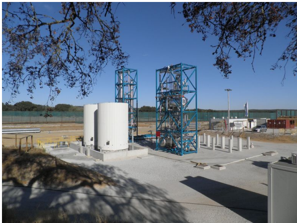
Fertiggestellte Speichertanks (weiße Tanks) und das Dampferzeugersystem (ohne komplettierten Stahlbau)
